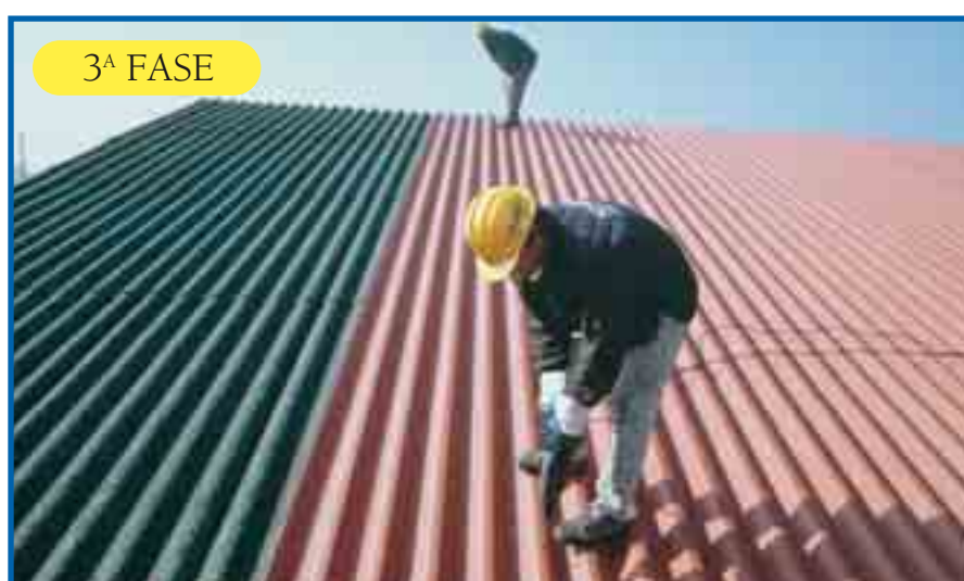
Fissaggio della lastra Eteral sulla vecchia copertura senza rimuovere il vecchio fissaggio con viti Alublok.
